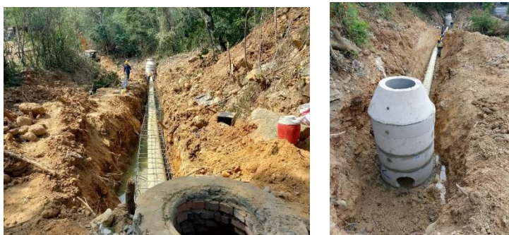
Ilustración 6-Obras Sector San Gregorio-Antonio Nariño
