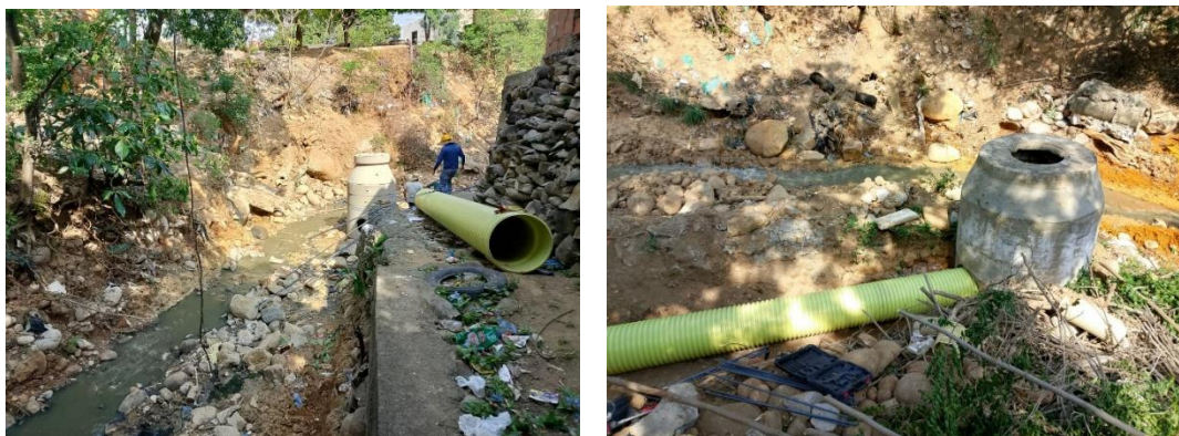
Ilustración 5-Obras Sector Santander-San Gregorio
